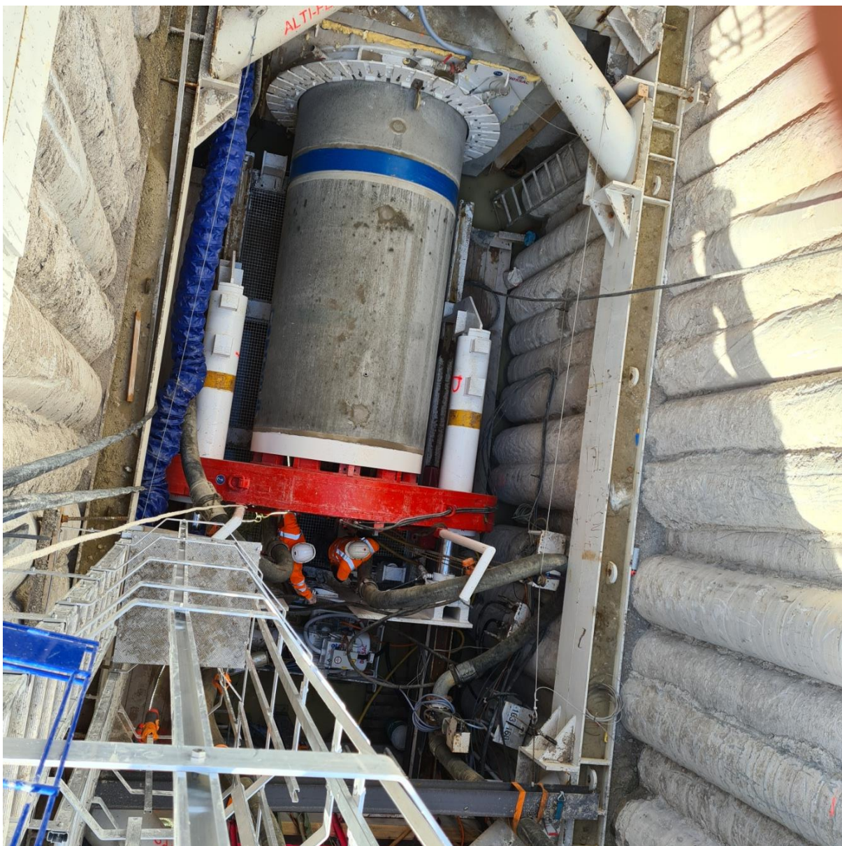
Station de poussée des tuyaux
